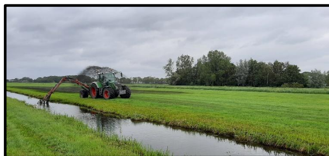
Ecologisch baggeren met de baggerpomp
